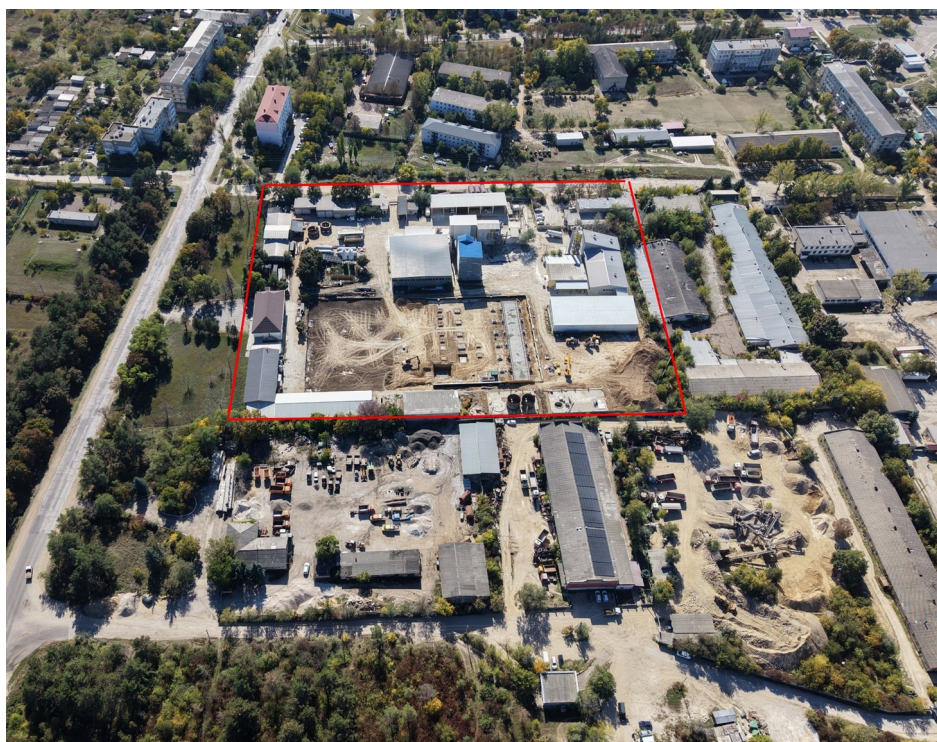
Fig. 3. Platforma industrială din Florești (str. Mihai Viteazul 31) – vedere aeriană; cu roșu – limitele terenului 4501212.180 (2,99 ha).
